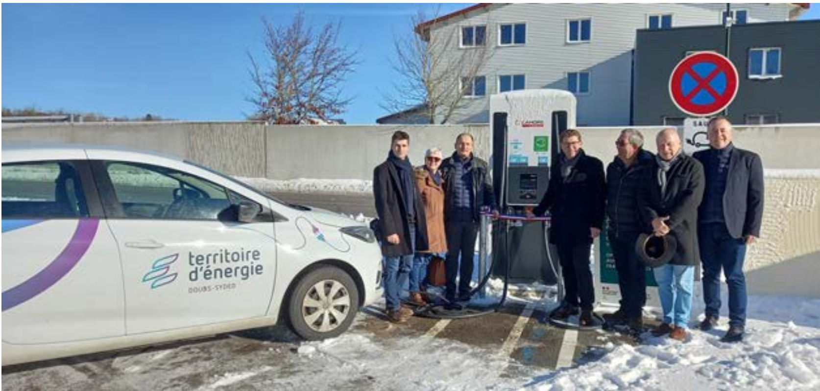
Le Bélieu • La zone d'activités du Bas de la Chaux est désormais dotée d'une borne de recharge rapide pour tous les véhicules électriques, afin de répondre aux besoins des usagers
