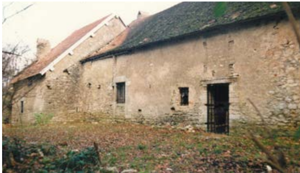
La ferme de l'Ermitage avant complète rénovation.
