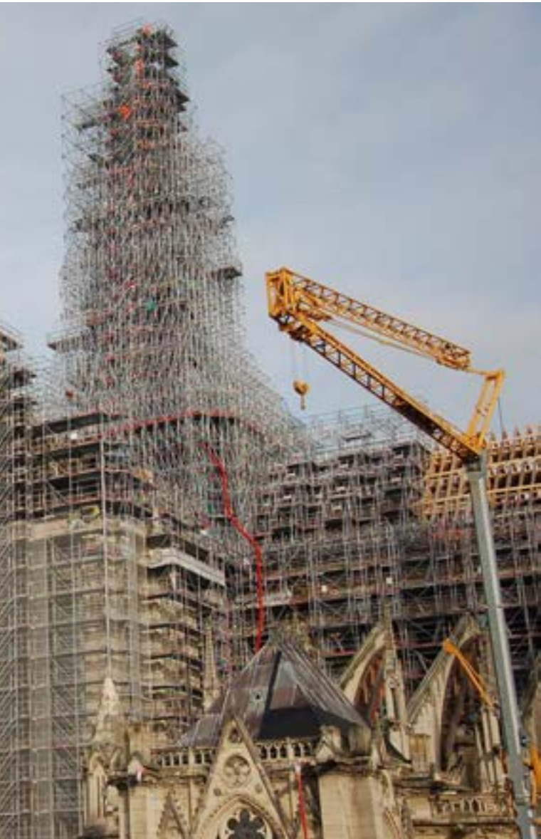
L'impressionnant échafaudage de la nouvelle flèche de Notre-Dame, qui culmine à 96 mètres de haut et sera identique à l'originale, dessinée par Eugène Viollet-le-Duc. Photo EBRA/RL/Ph.M.
